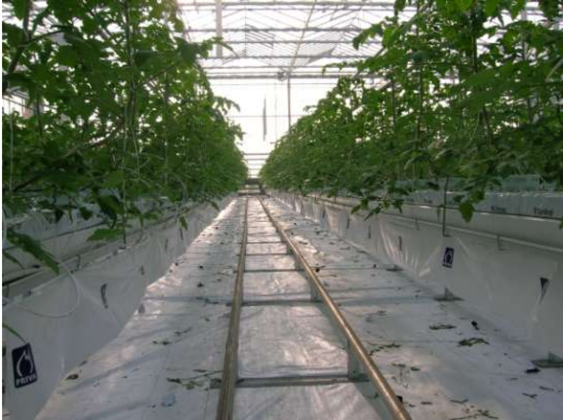
Figuur 3: Inpassing van de luchtslangen in Het Nieuwe Telen
